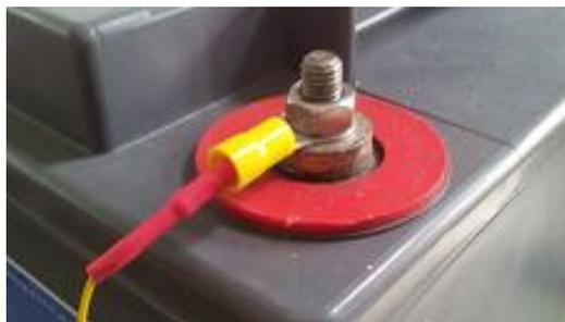
Figure 5 Cosse à œil sur le plot positif de l'élément de batterie
